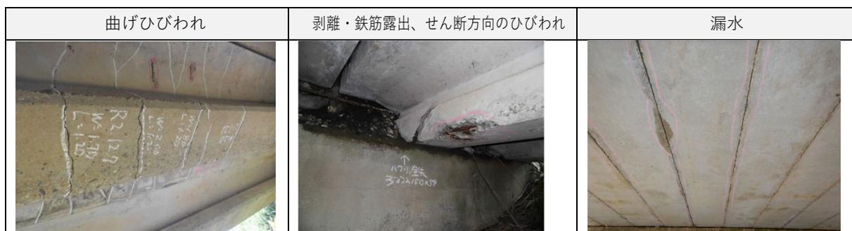
図 2-8 小規模橋梁の代表的な損傷
